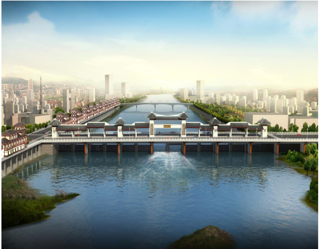
照片 1：广汉市金雁湖公园闸坝工程
