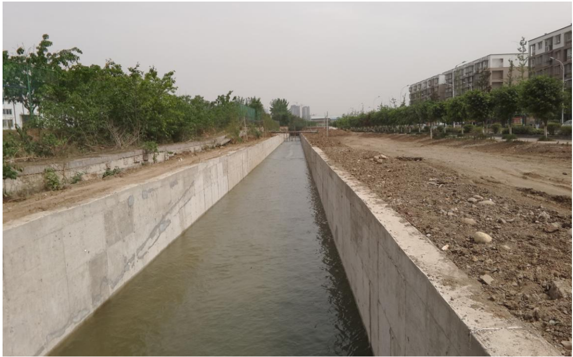
照片 11：德阳经开区柳梢堰渠道整治工程
