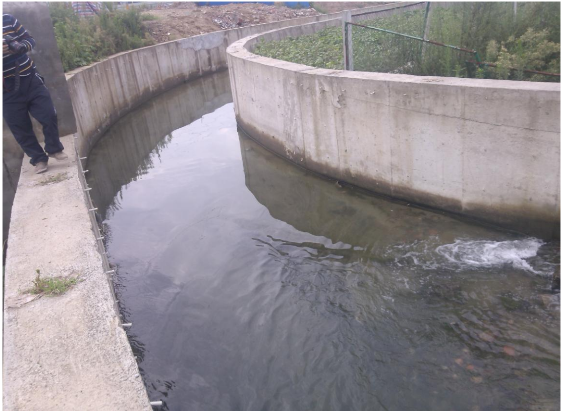
照片 9：人民渠 31 支渠整治工程
