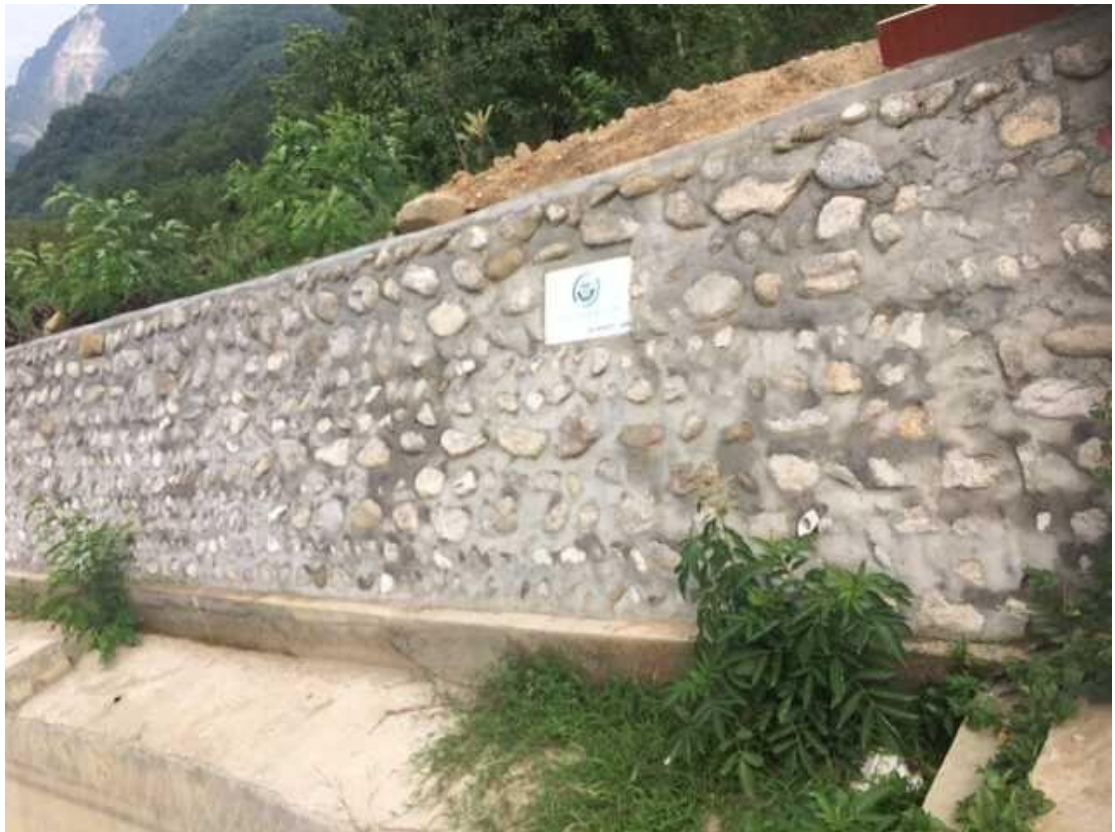
照片 12：绵竹市水土保持莲花沟小流域治理项目照片
