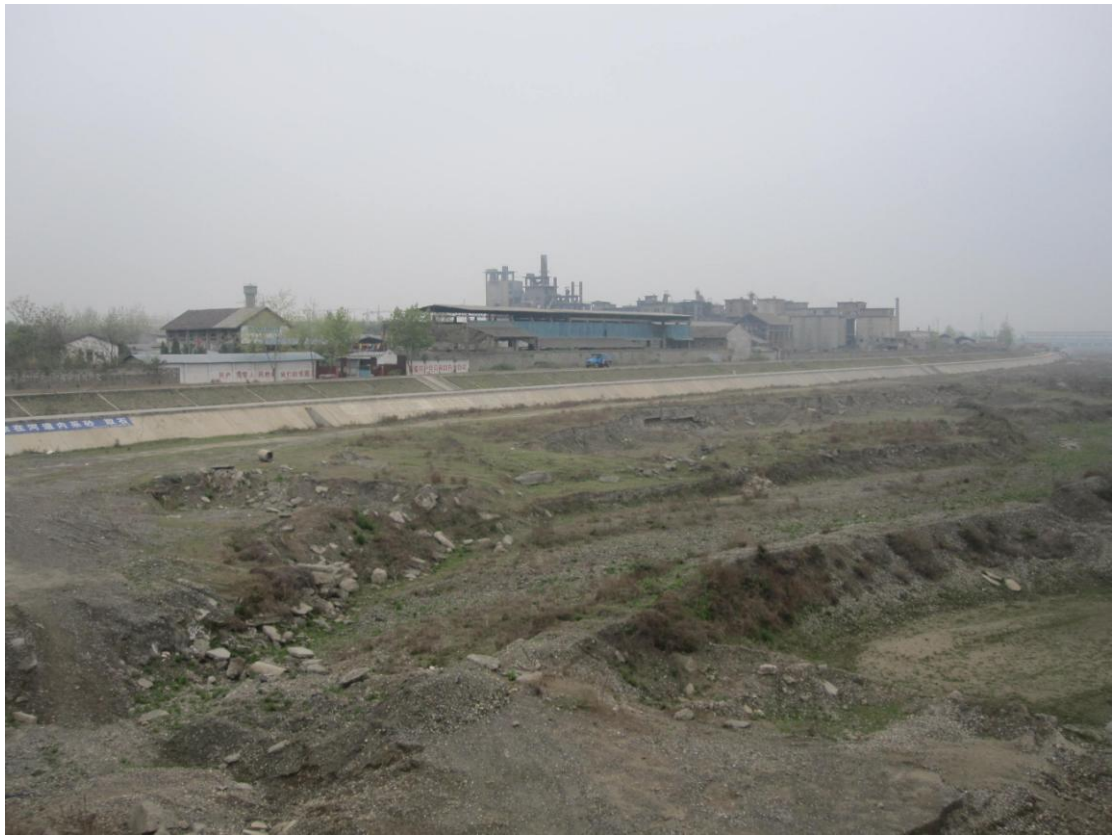
照片 6：绵远河 7.9 洪灾水毁修复工程照片
