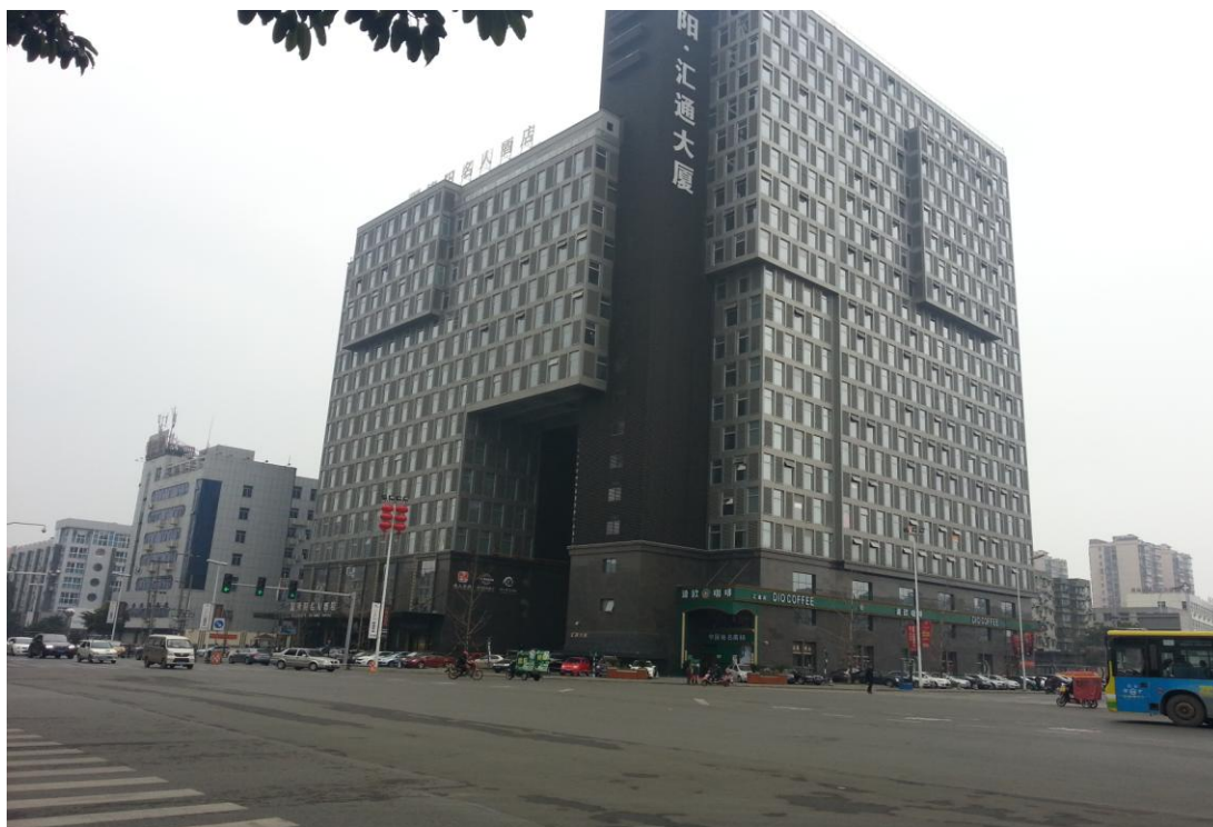
照片一：公司写字大楼（德阳市区岷江西路汇通大厦）
