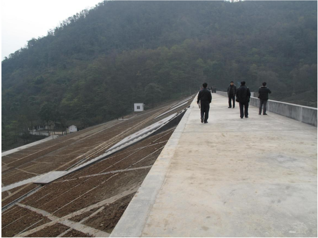
照片 5：广汉市梅家堰水库除险加固工程照片
