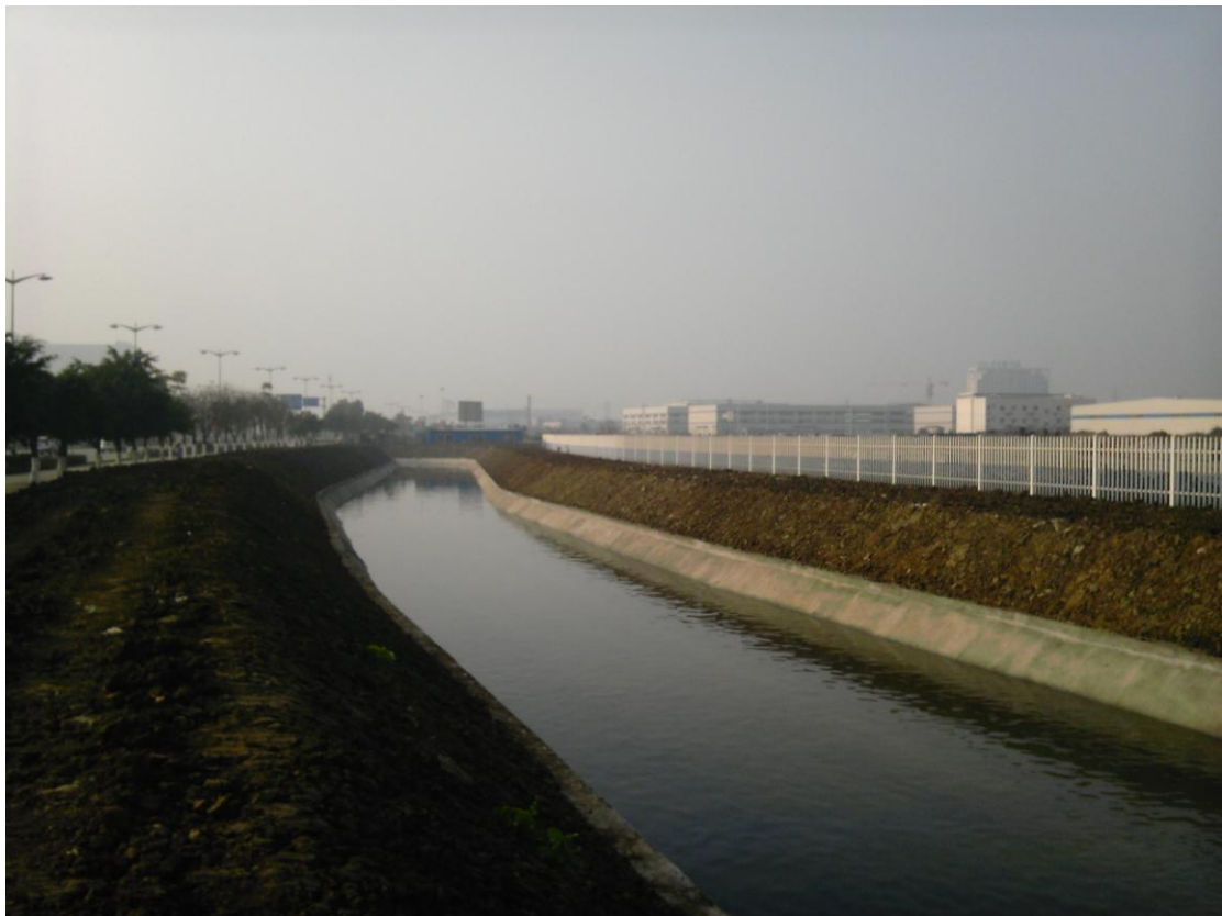
照片 10：人民渠 29 支渠整治工程
