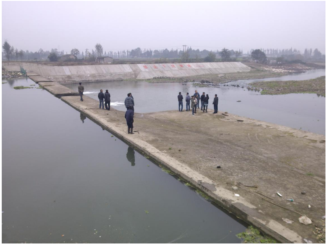
照片 7：绵竹市雷家堰拦河坝水毁修复工程
